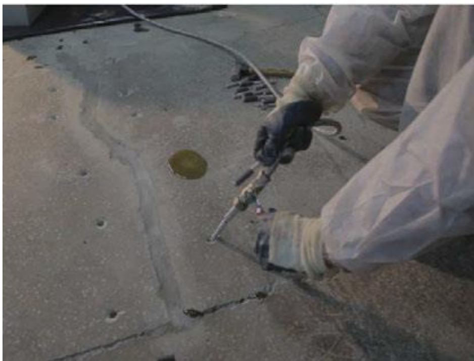
Рисунок 4 – Выполнение инъекционных работ
