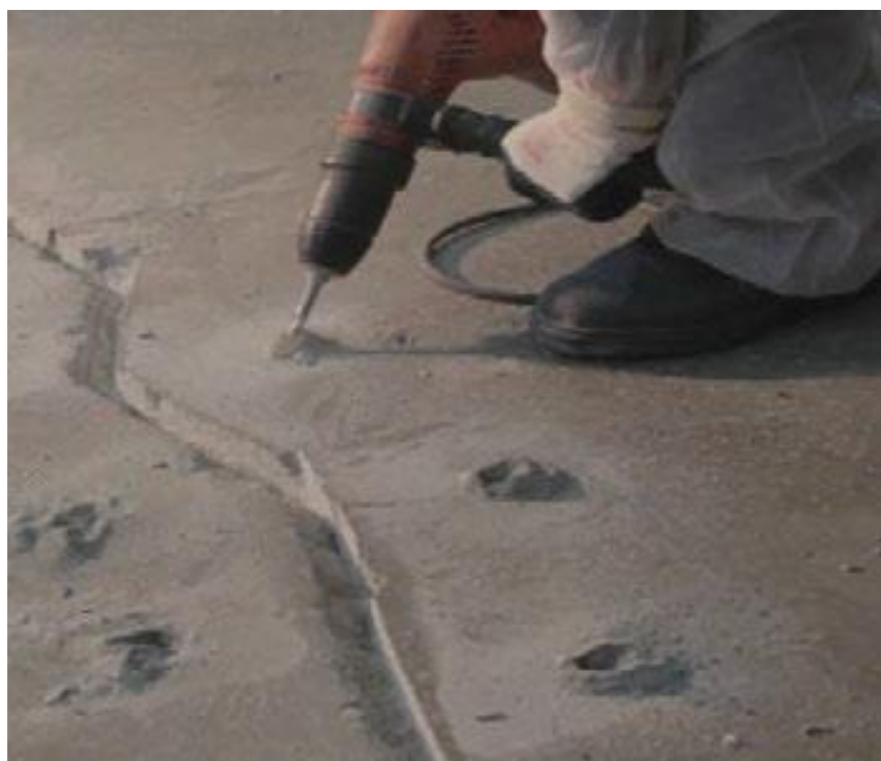
Рисунок 3 – Бурение отверстий для установки инъекторов
